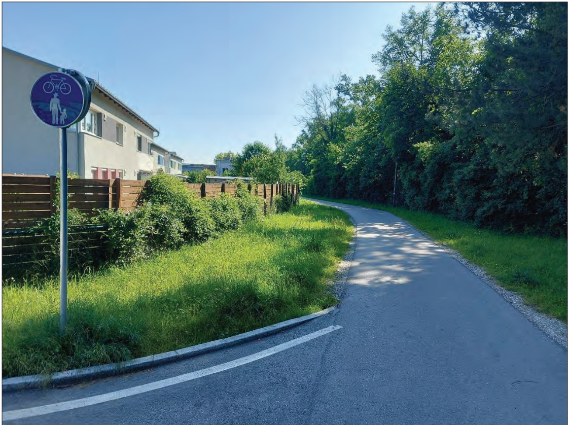
Abbildung 149: Geh- und Radweg zwischen Lärchenstraße u. Pulverturmstraße (e.Abb.)
