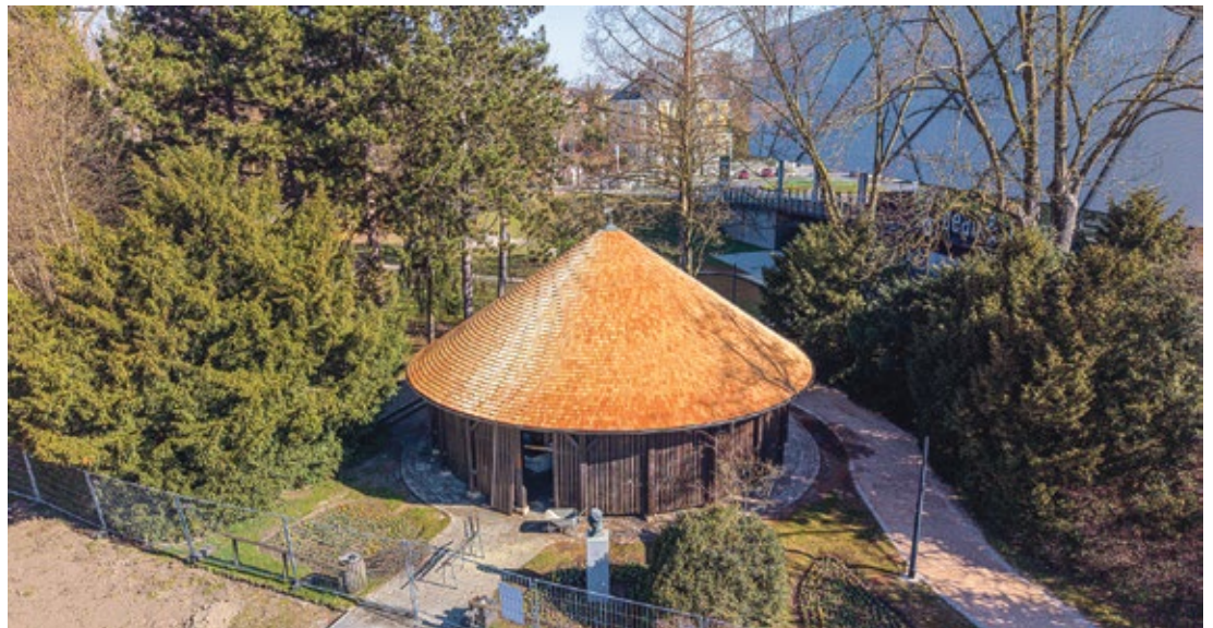
Gesunde Salzlufte schnuppern kann man wieder im Gradierwerk nach dessen Erneuerung.
