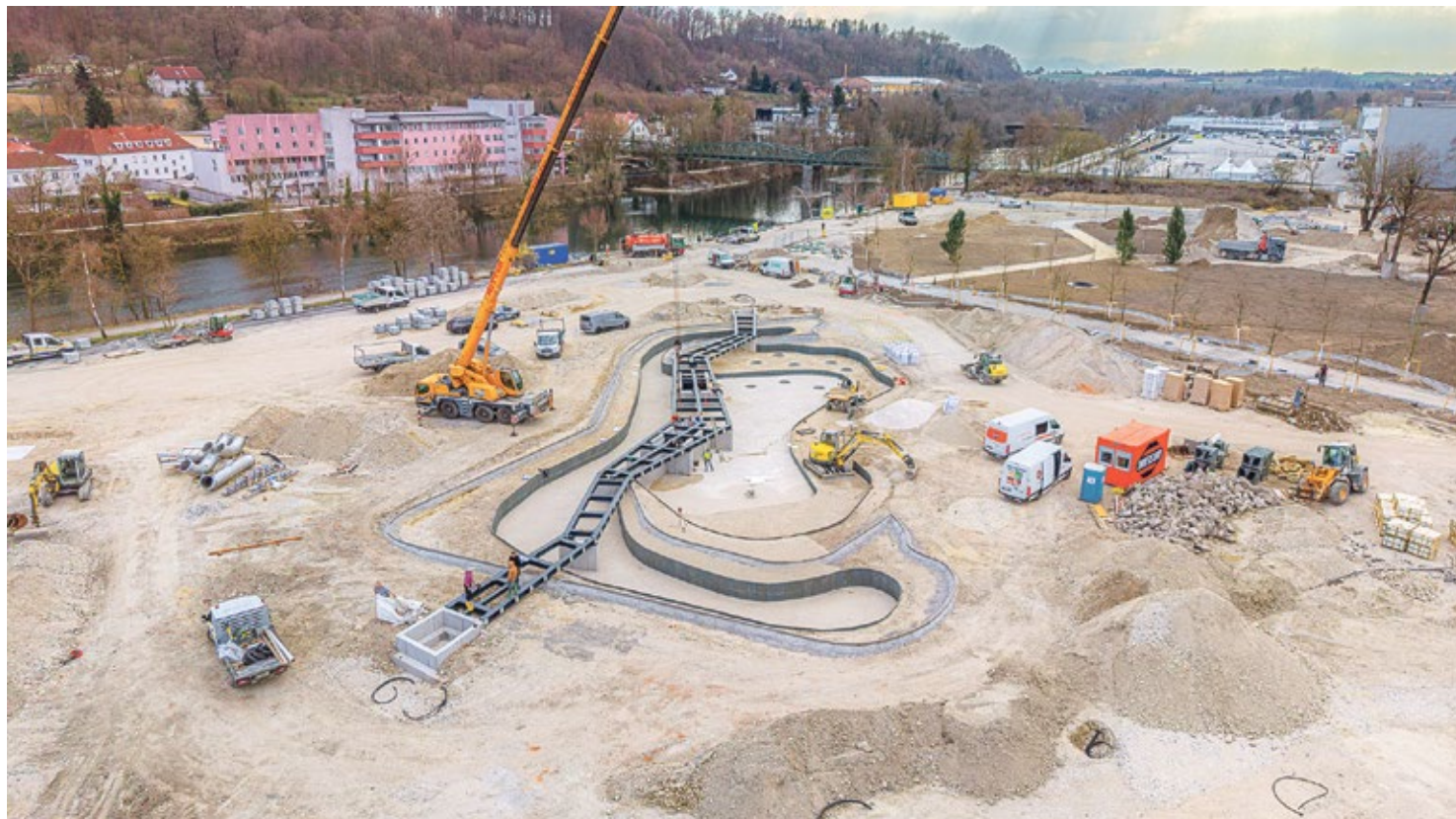
Bereits sehr gut erkennbar ist der künftige Seerosenteich mit seinem Steg.
