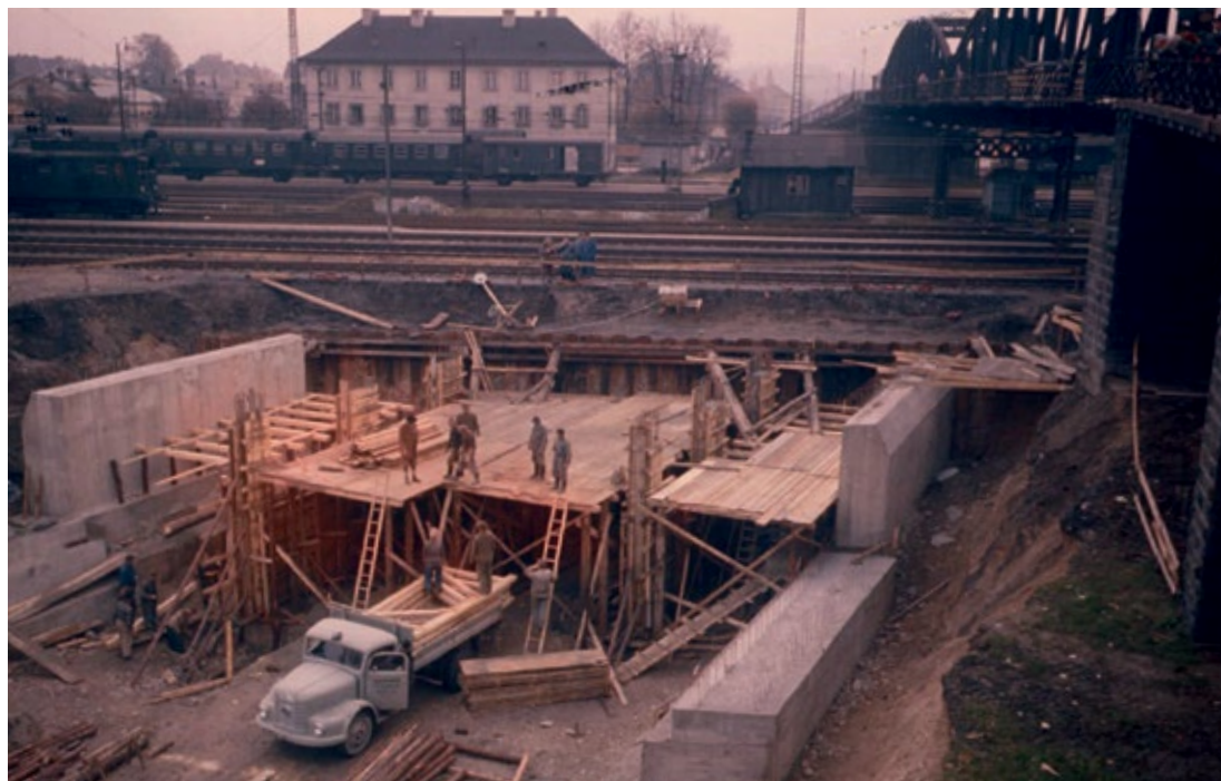
Während die Karlsbrücke noch stand, wurde 1958 und 1959 bereits eifrig an der Neustadt-Unterführung gebaut. Diese ist seit 1960 in Betrieb und präsentiert sich zudem seit 2021 künstlerisch verschönert.
