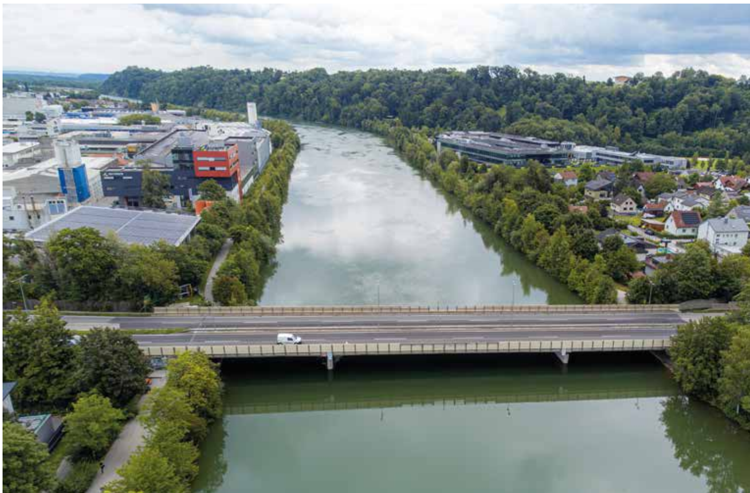
Zur Unterscheidung von der im Mai-Amtsblatt vorgestellten „Alten Traunbrücke“ wird die Osttangente-Brücke auch als „Neue Traunbrücke“ bezeichnet. Im Bild oben eine aktuelle Ansicht, auf der gegenüberliegenden Seite Ansichten der Baustelle und der frühen Betriebsjahre.
