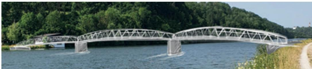
Variante 3: Bogenförmige Fachwerkbrücke aus Aluminium.
